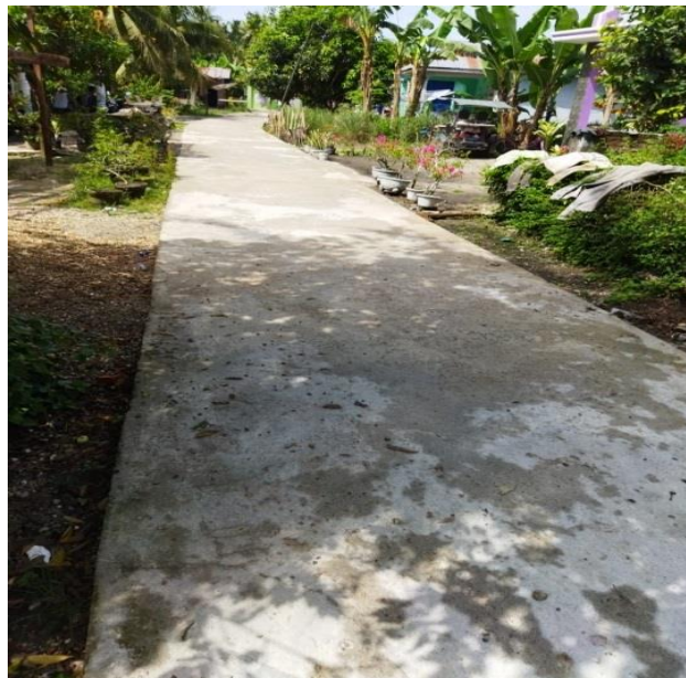
Gambar 1. Pembangunan Jalan Rabat Beton Desa Simpang Empat
